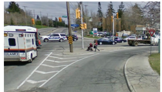
Figure 2.16 : Les voies de virage vers la droite comportant un îlot de séparation peuvent rendre les intersections désagréables pour les piétons
