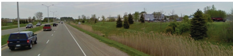
Figure 2.28 : Rigole de drainage biologique
