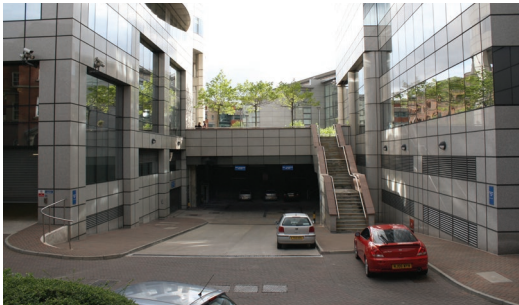
Figure 3.15 : Immeuble à bureaux avec quai de chargement en retrait
