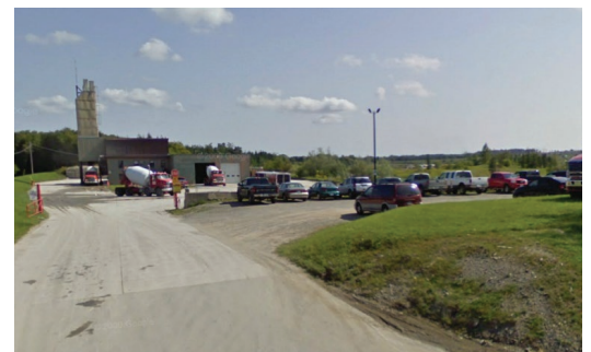
Figure 2.36 : Entrée pour camions dans une installation minière / d'agrégats
