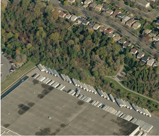
Figure 2.24 : Zone tampon paysagée comportant des conifères pour aider à réduire le bruit provenant de la route dans la zone d'emploi
