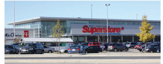
Figure 3.22 : Exemple de magasin à grande surface
