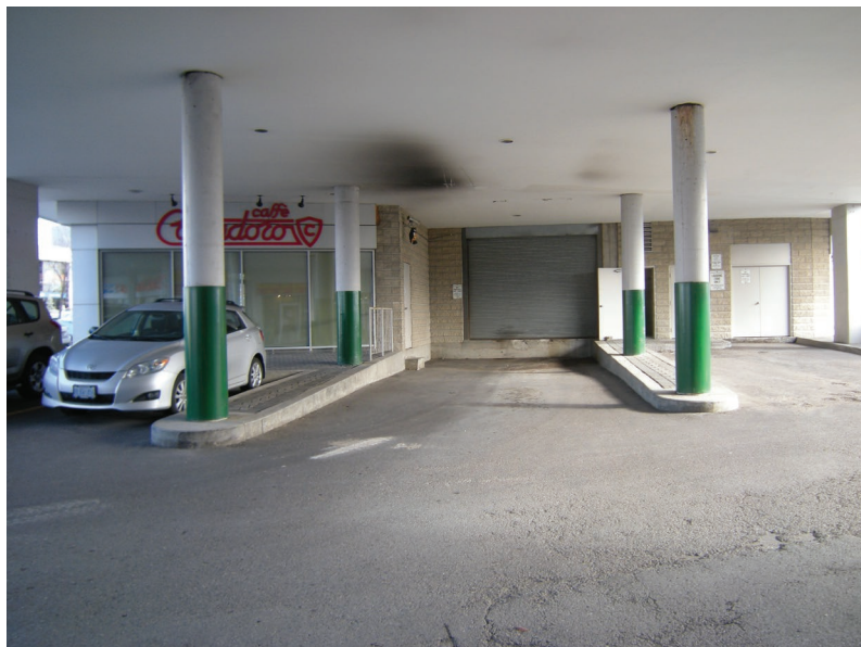
Figure 3.25 : Installations de chargement partagées dans un centre commercial linéaire
