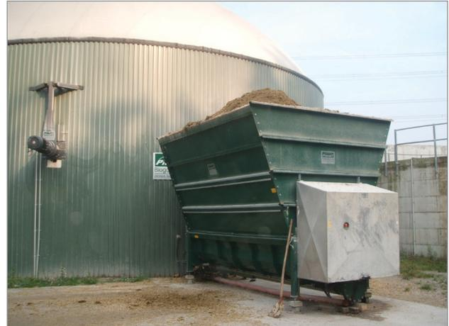
**Figure 3.** Trémie remplie de maïs à ensilage destiné à être incorporé au contenu du digesteur.
