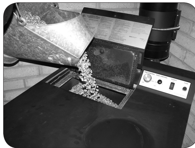
Figure 2. Un vieux seau à charbon peut être utilisé pour alimenter la trémie à combustible à l'arrière du poêle.
