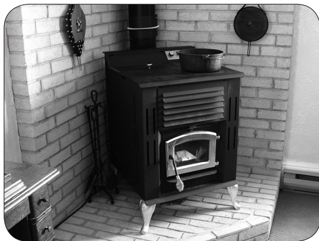
Figure 1. Poêle à maïs placé en coin dans unâtre recouvert de briques ventilées sur les deux murs adjacents. La brique offre une protection pare-feu autour du poêle.
