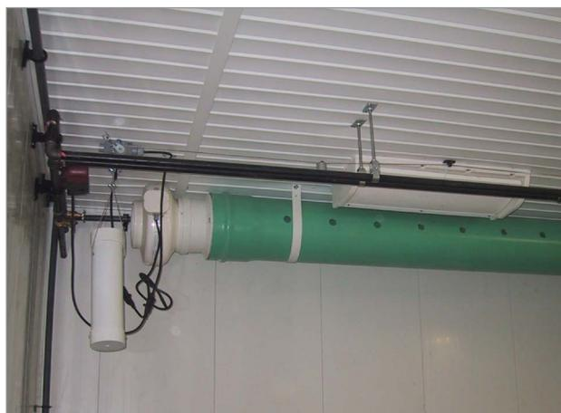
**Figure 3.** Installation constituée d'un conduit rigide relié à un ventilateur soufflant et percé de trous de distribution, qui améliore la circulation de l'air.
