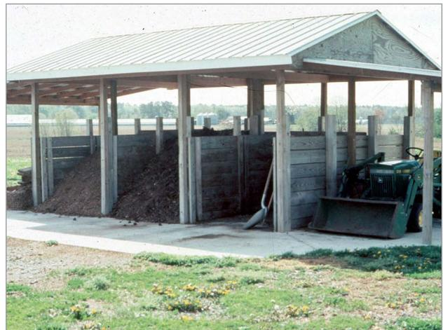
**Figure 3.** Système de compostage à trois silos-couloirs.
