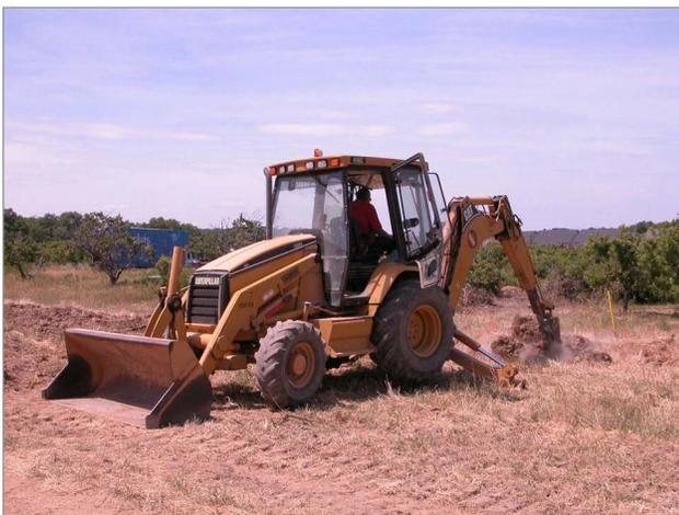
**Figure 8.** Excavation d'une fosse d'enfouissement à l'aide d'une pelle rétrocaveuse.
