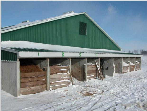
**Figure 2.** Système réel montrant deux cellules primaires et secondaires, des cellules contenant du compost mûr et des cellules pour le stockage de substrat.
