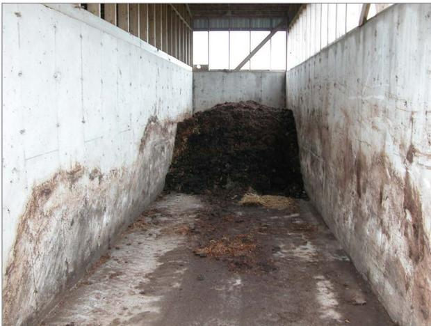
**Figure 4.** Ces murs de béton ont 2,4 m (8 pi) de hauteur, mais le compost n'est jamais empilé sur plus de 1,8 m (6 pi) de hauteur. Si c'était à recommencer, l'exploitant aurait construit une cellule 0,6 m (2 pi) plus large que sa chargeuse, qui passe difficilement dans une cellule aussi longue et étroite que celle-ci.
