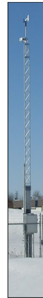
Ci-dessus : Tour du Système d'information météorologique (SIM). Le MTO se sert des données en temps réel générées par le SIM et des prévisions pour prendre des décisions en temps réel au sujet des restrictions de charge printanières et des primes de poids hivernales.
