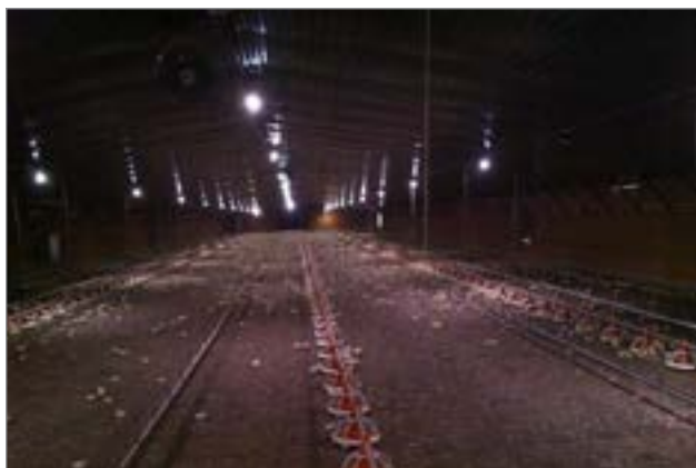
Figure 6. Poulailler éclairé par des lampes à DEL de 12 W espacées de 7,3 m (24 pi).
