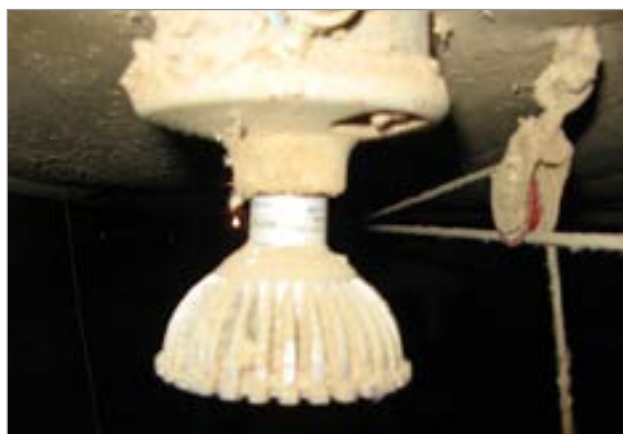
Figure 8. Modèle différent d'ampoule à DEL pourvue d'ailettes couvertes d'une couche de poussière.
