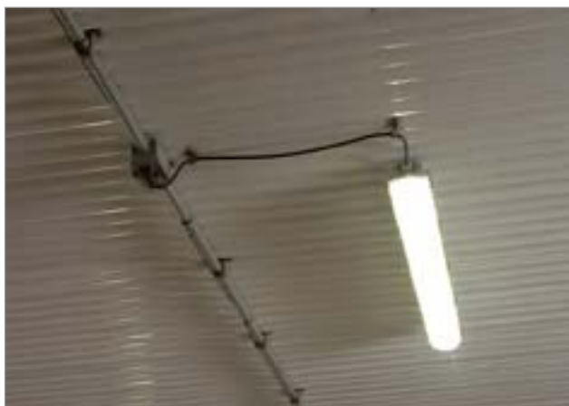
Figure 10. Luminaire fermé à tube à DEL. Le tube à DEL remplace un tube fluorescent T8 dans le même luminaire.
