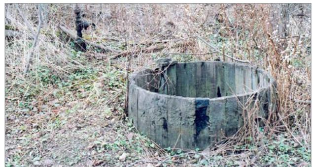
Figure 2. Vieux puits de pétrole avec réservoir de stockage en bois.
