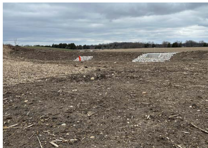
Figure 7-11. Berme construite avec plusieurs sorties, conçue pour stocker de l'eau temporairement dans le paysage.
