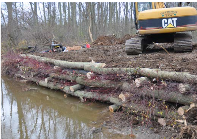
Figure 7-8. Construction d'un caisson végétalisé.
