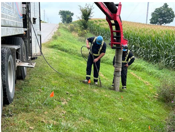
Figure 2–9. Exemple des coûts accrus requis pour une traverse routière en raison de l'hydro-excavation de services publics.
