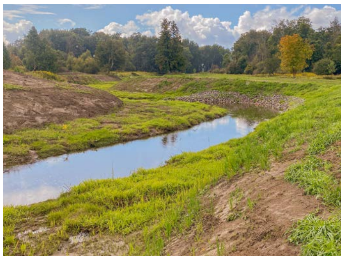
Figure 7-1. Installation de drainage du ruisseau South Innisfil avec l'aménagement d'un chenal naturel sinueux. Source : Ville d'Innisfil, Ontario
