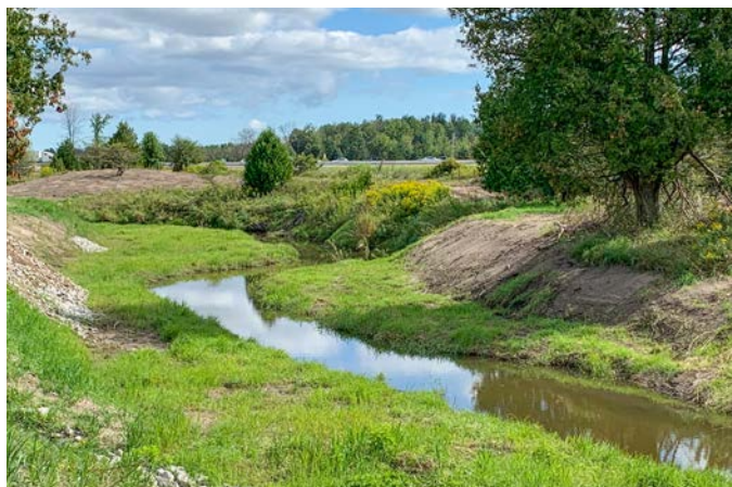
Figure 7-2. Installation de drainage du ruisseau South Innisfil avec des bandes tampons riveraines le long du cours d'eau. Source : Ville d'Innisfil, Ontario
