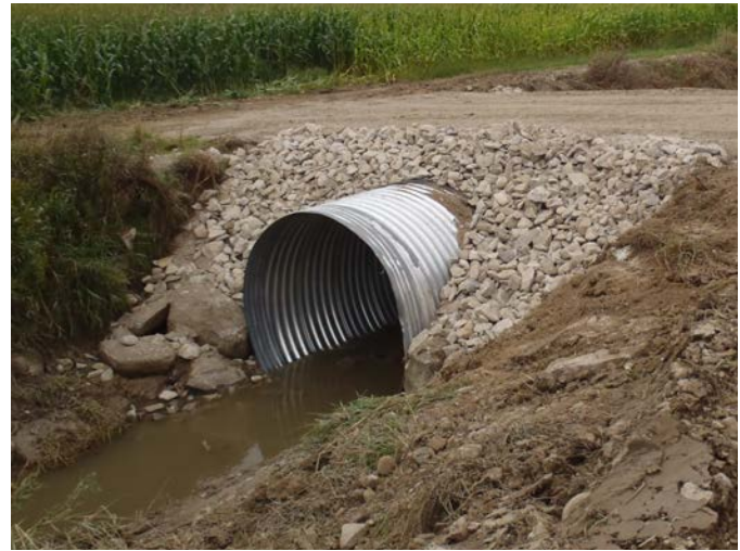
Figure 3-1. Traverse plus large récemment installée au-dessus d'un drain.
